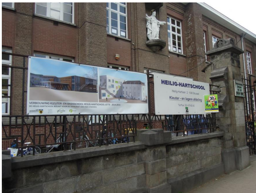
Renovatie en capaciteitsuitbreiding van de Heilig-Hartschool in Jette in 2014
