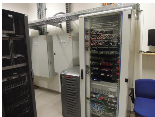
De serverruimte van Don Bosco Halle, een voorproefje van de vorming 'elektrische installaties' op 21 maart 2017 in de nijverheidsschool
